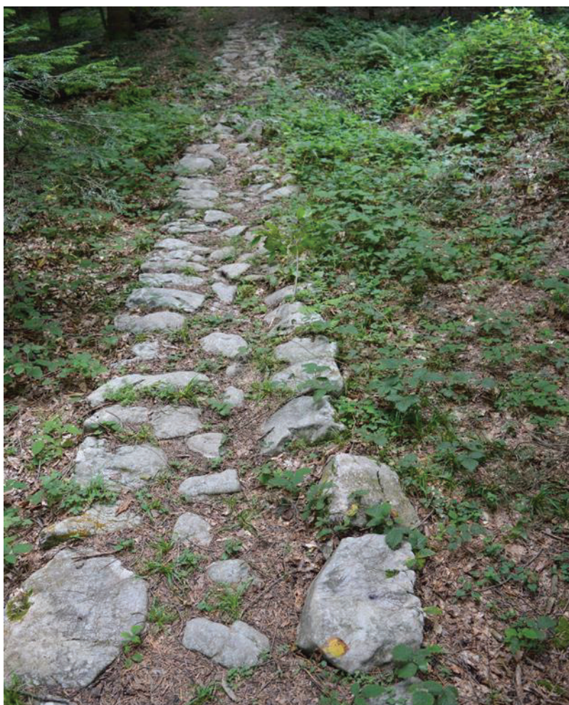
Sl. 1. Miljkovac, osmanski karavanski put. Zatečeno stanje (foto: M. Imamović)
